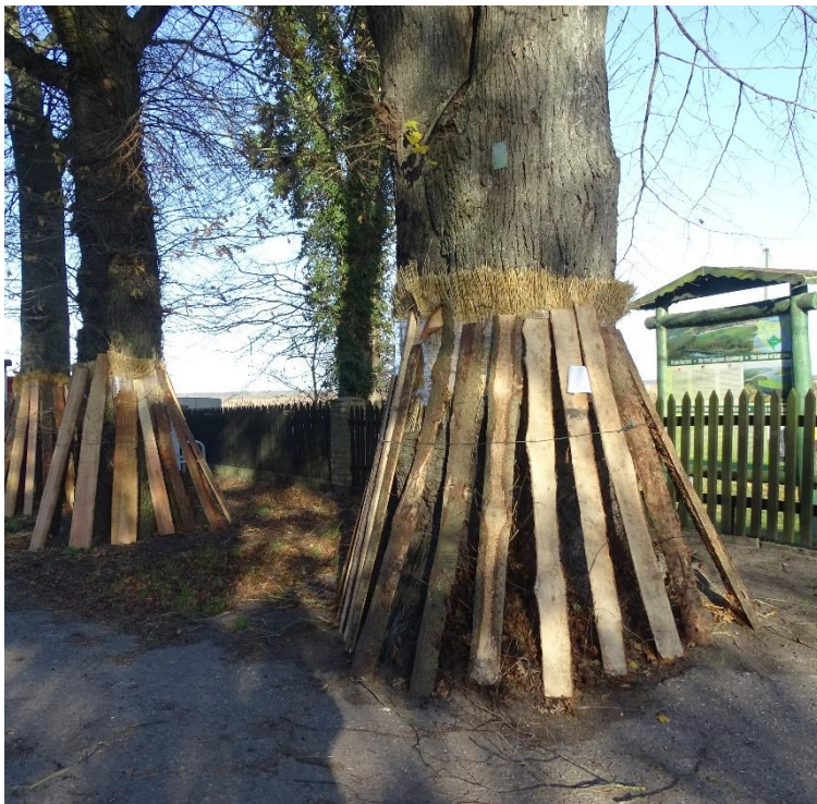
Fot. 1. Przykładowe zabezpieczenia pnia drzewa z zastosowaniem odeskowania i mat słomianych, deski nie opierają się o nabiegi korzeniowe, mata wystaje ponad odeskowanie.
